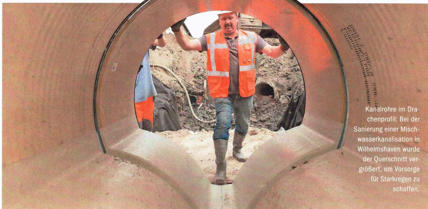
Kanalrohre im Drachenprofil: Bei der Sanierung einer Mischwasserkanalisation in Wilhelmshaven wurde der Querschnitt vergrößert, um Vorsorge für Starkregen zu schaffen.
