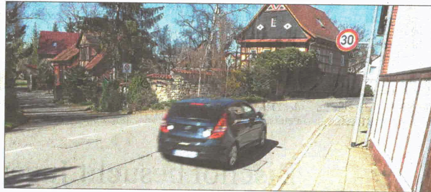
Das Fachwerkhaus in der Bildmitte steht direkt an der Linderbacher Straße. Das Tiefbauamt will bei den anstehenden Kanalarbeiten die Straße einengen. Foto: Marco Schmidt
