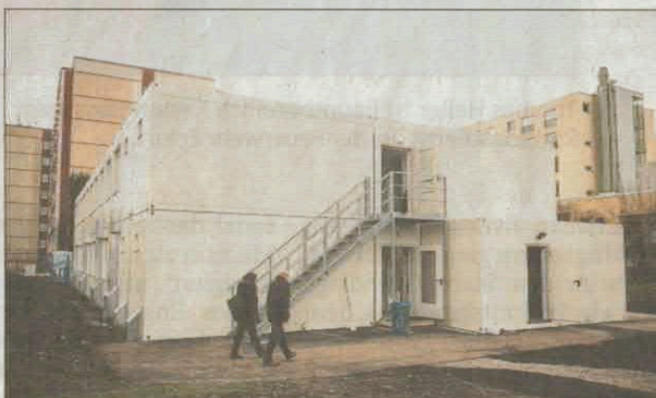
Der Zugang zur oberen Etage erfolgt über eine seitliche Treppe. Vorgelagert ist ein Container für technische Anschlüsse.
