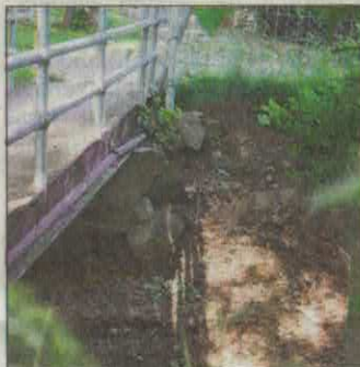
Die Fußgängerbrücke am Sportplatz in Büßleben wird nach Ostern neu gebaut. Foto: privat
