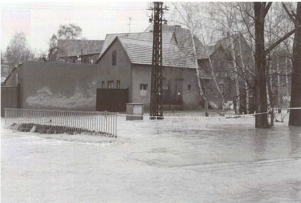
Hochwasser am 14. April 1994 in Büßleben.
