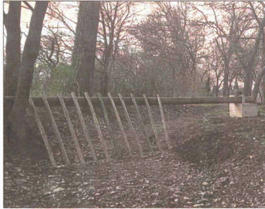
Die Geröllsperre am Peterbach oberhalb von Büßleben ist fertig gestellt. Foto: Kathrin Hörr
