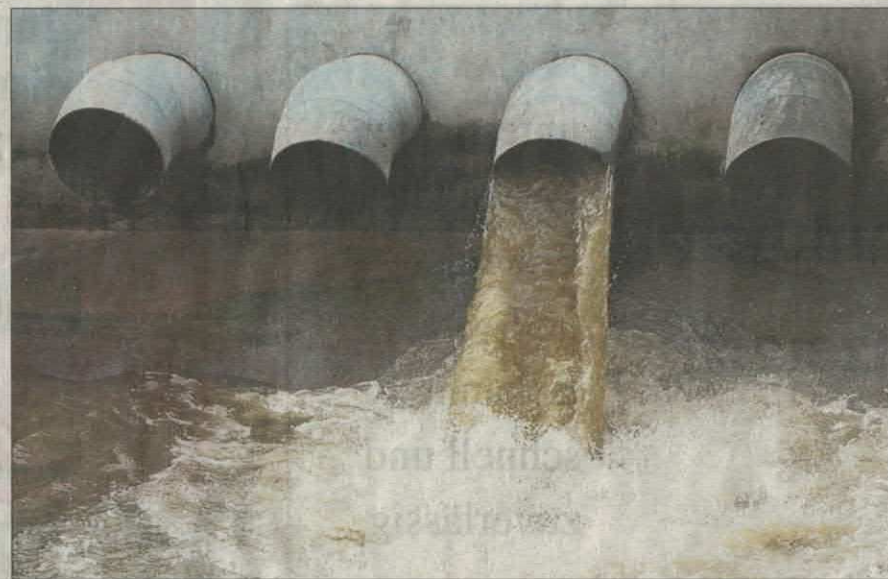
Für den Weg des Abwassers ins Klärwerk werden in Erfurt immer noch verschiedene Gebühren berechnet.
