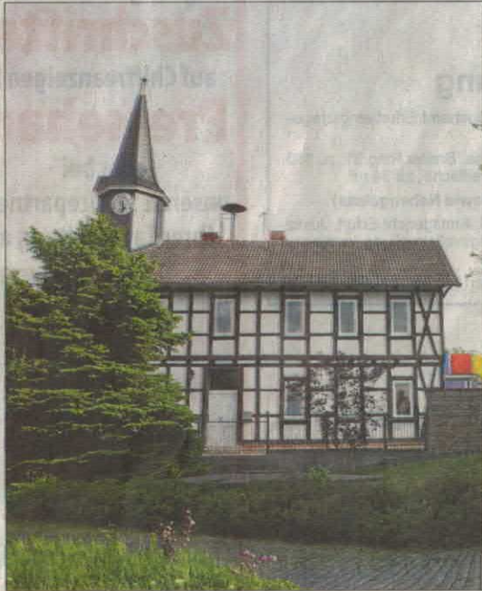
Die Sirene auf der Kita soll die Büßlebener künftig vor Hochwasser warnen. Foto: Holger Wetzel
