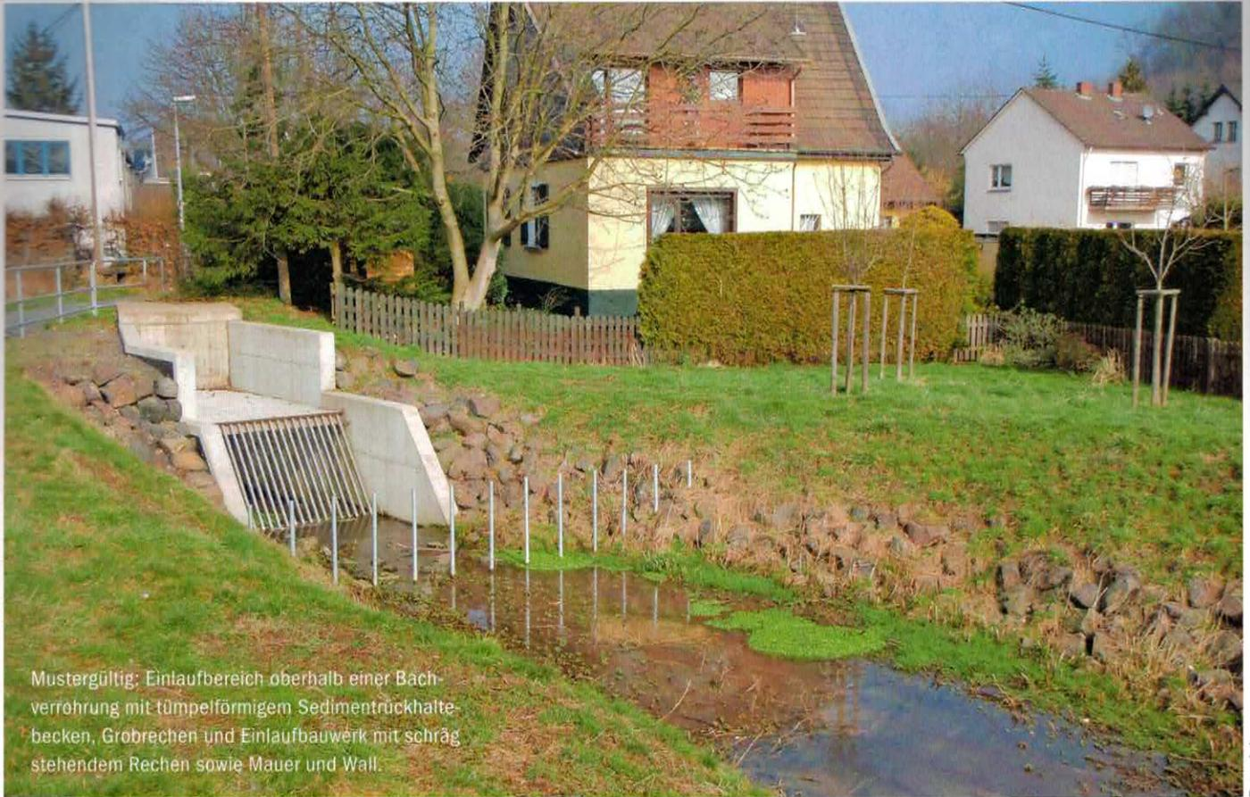
Mustergültig: Einlaufbereich oberhalb einer Bachverrohrung mit tümpelförmigem Sedimentrückhaltebecken, Grobrechen und Einlaufbauwerk mit schräg stehendem Rechen sowie Mauer und Wall.
