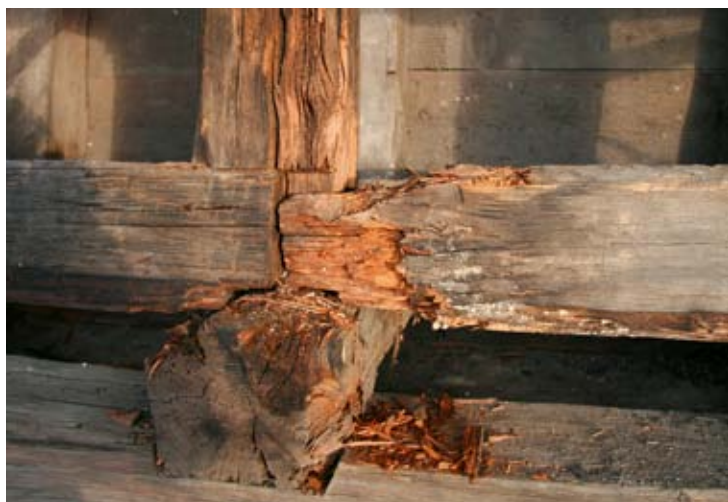
Schäden an den Dachbalken
