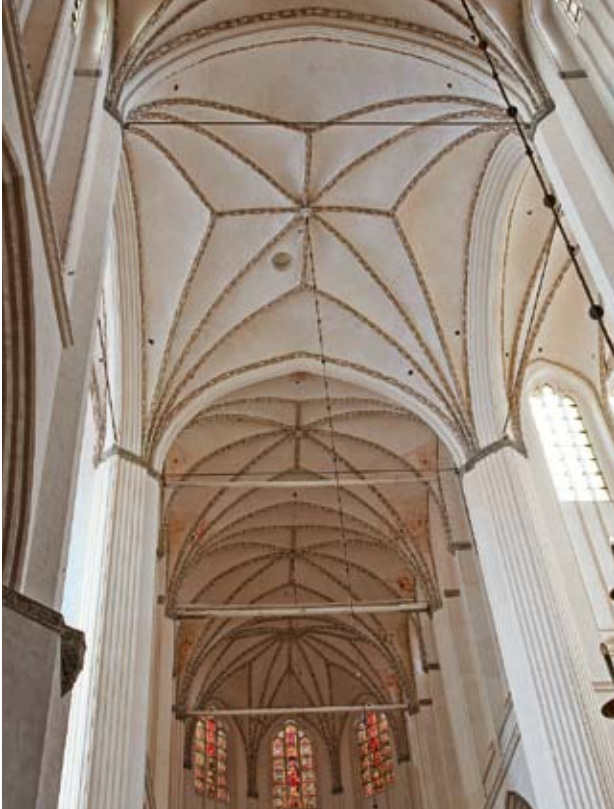
Kirche St. Marien zu Rostock: Sterngewölbe nach der Restaurierung im Jahr 2008
