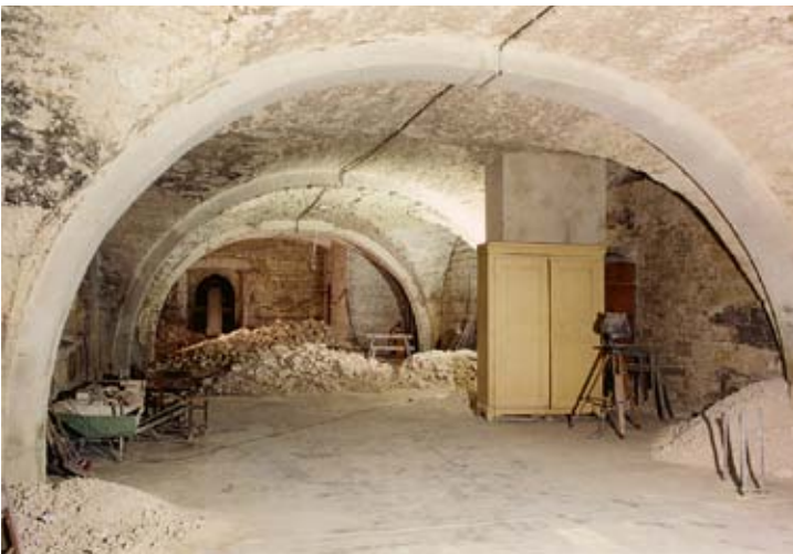
Naumburger Domschatzgewölbe vor und nach der Restaurierung 2006
