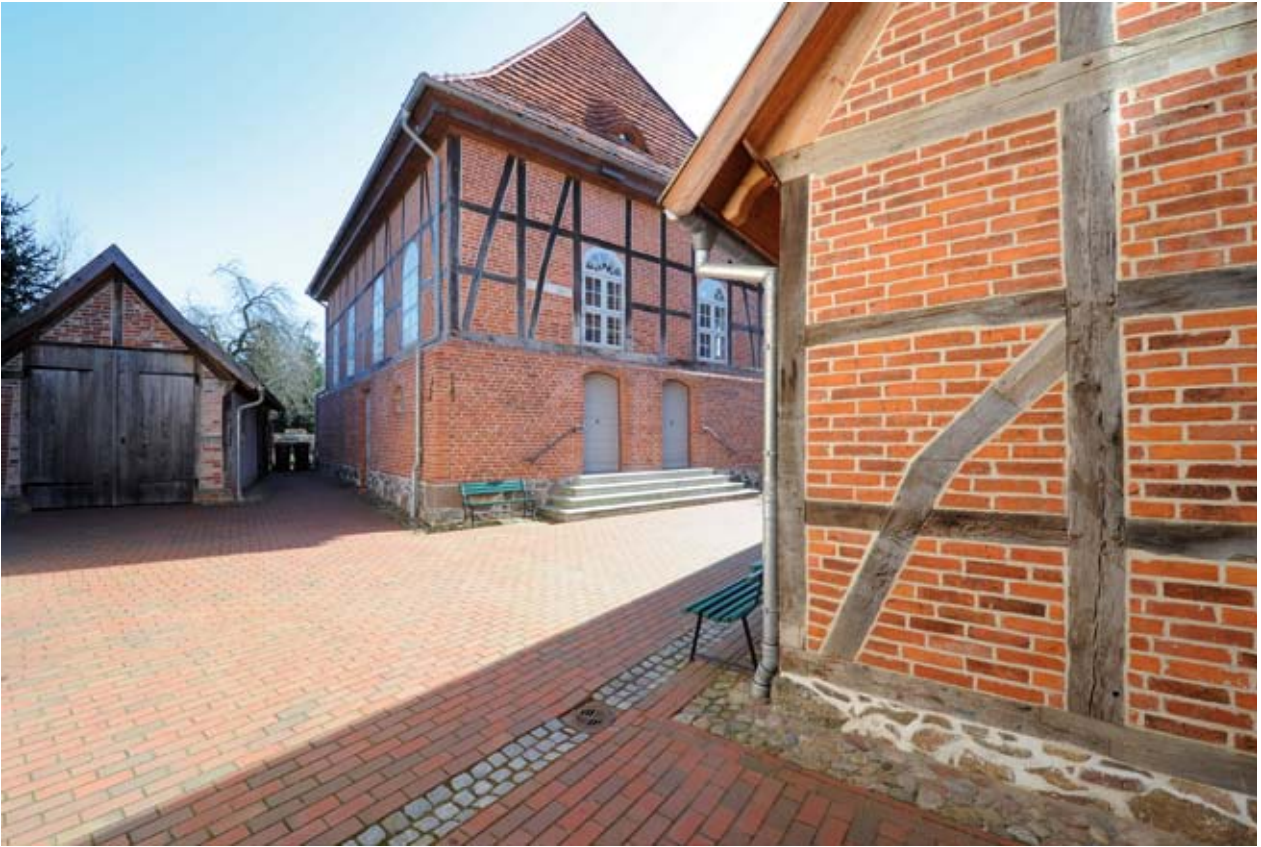
Alte Synagoge in Hagenow: Gesamtensemble mit Bethaus, Gemeindehaus und Remise für den Leichenwagen
