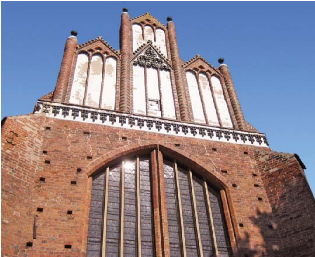
Kirche St. Georgen in Parchim: Blick auf den Blendgiebel des Südanbaus
